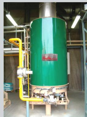
**Aufbau** Der Clayton Abgaskessel besteht aus Segmenten, welche einfach als Modul zusammengebaut werden um einen optimalen Wärmetransfer zu ermöglichen.
